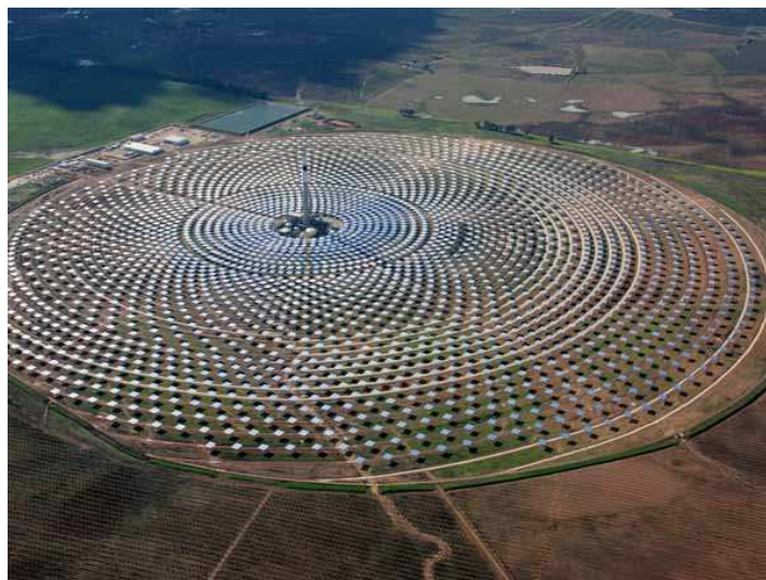
Centrale thermodynamique à tour
