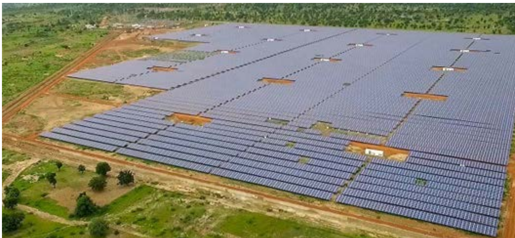
Centrale photovoltaïque de Zagtoui au Burkina Faso
